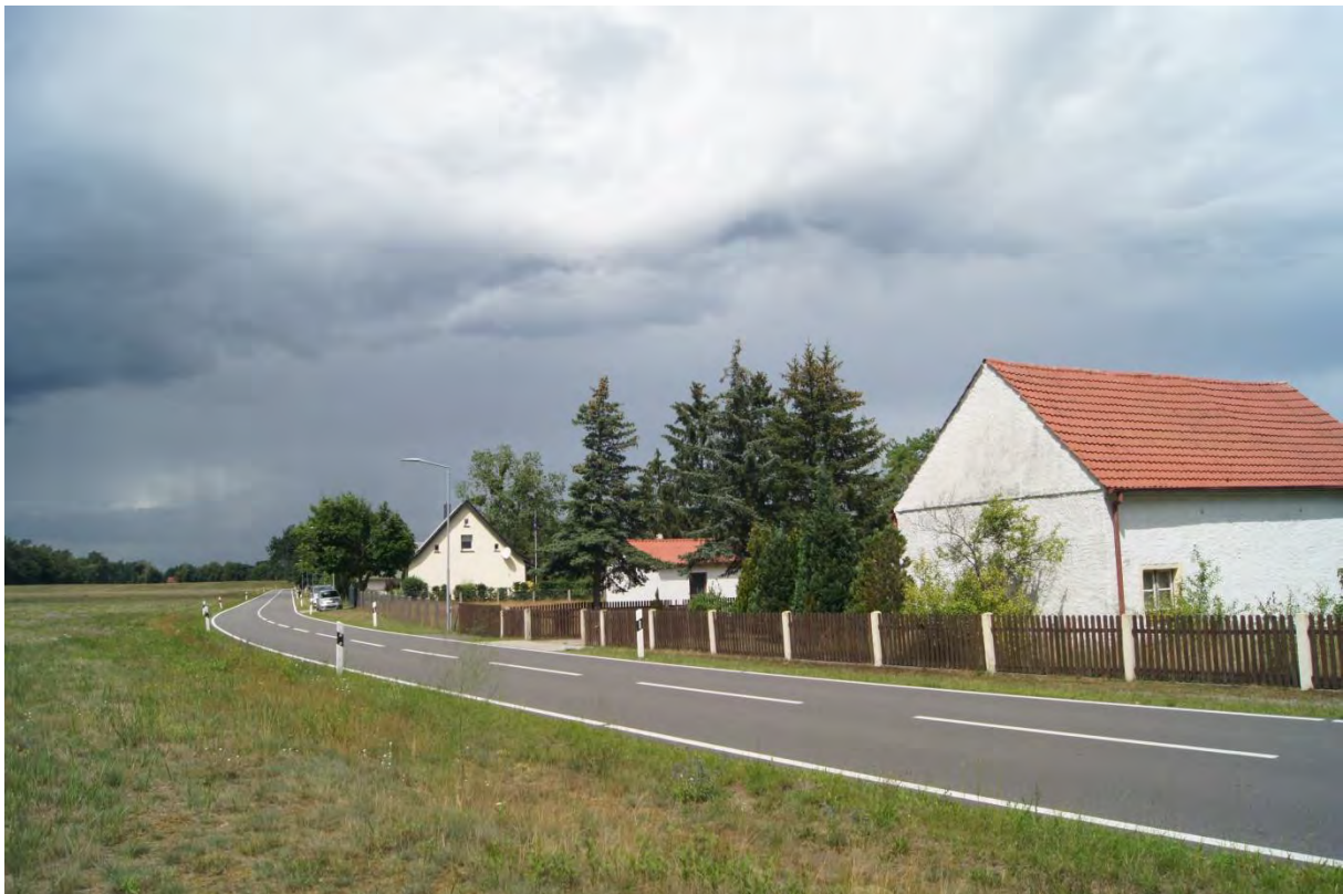
Bild 16 nördlich der L28 bebaute Wohngrundstücke mit brachgefallenen Flächen
